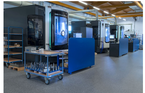
Moderne Arbeitsplätze mit Luftaustauschsystem
